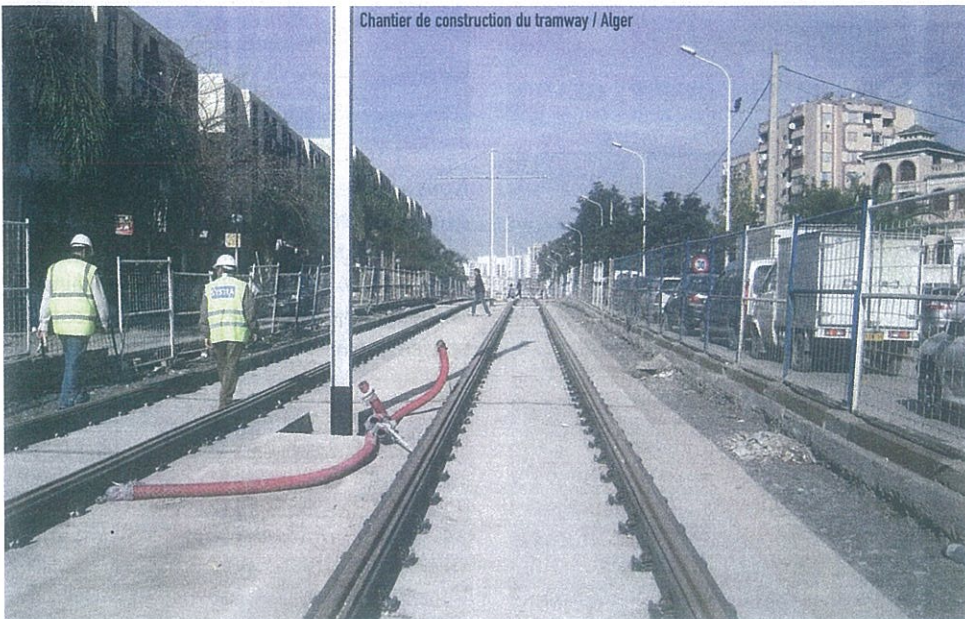
Chantier de construction du tramway / Alger
