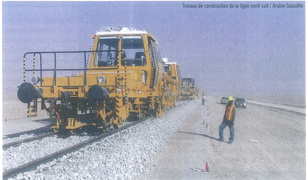
Travaux de construction de la ligne nord sud / Arabie Saoudite
